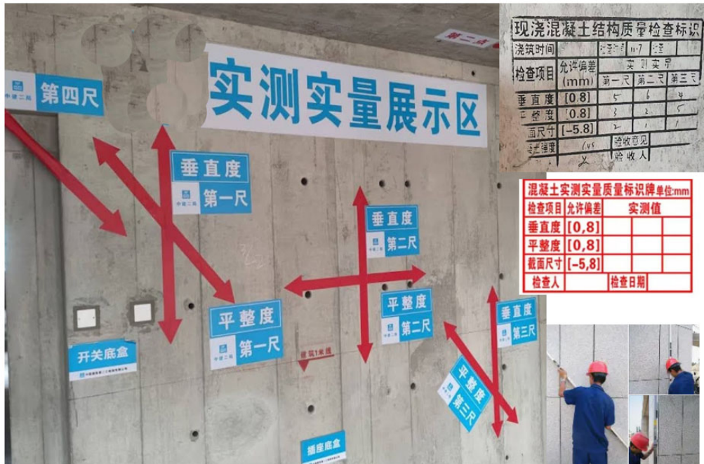
圖三 鋁模完成面品保量測四尺位置
