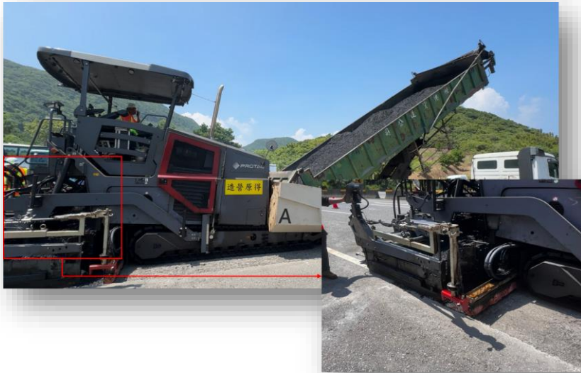
自動黏層撒佈鋪裝機之應用情形
