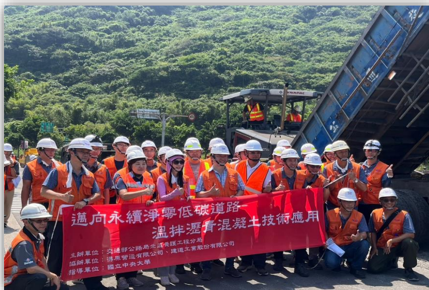
溫拌瀝青混凝土於省道應用之情形
