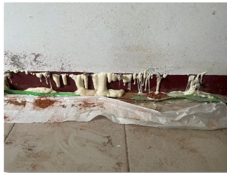
磚牆裂縫灌注發泡劑
