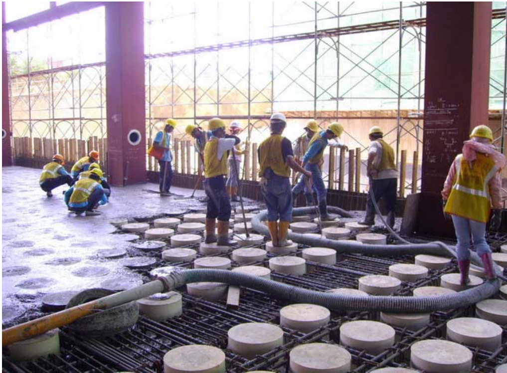
鋼筋綁紮與混凝土澆置
