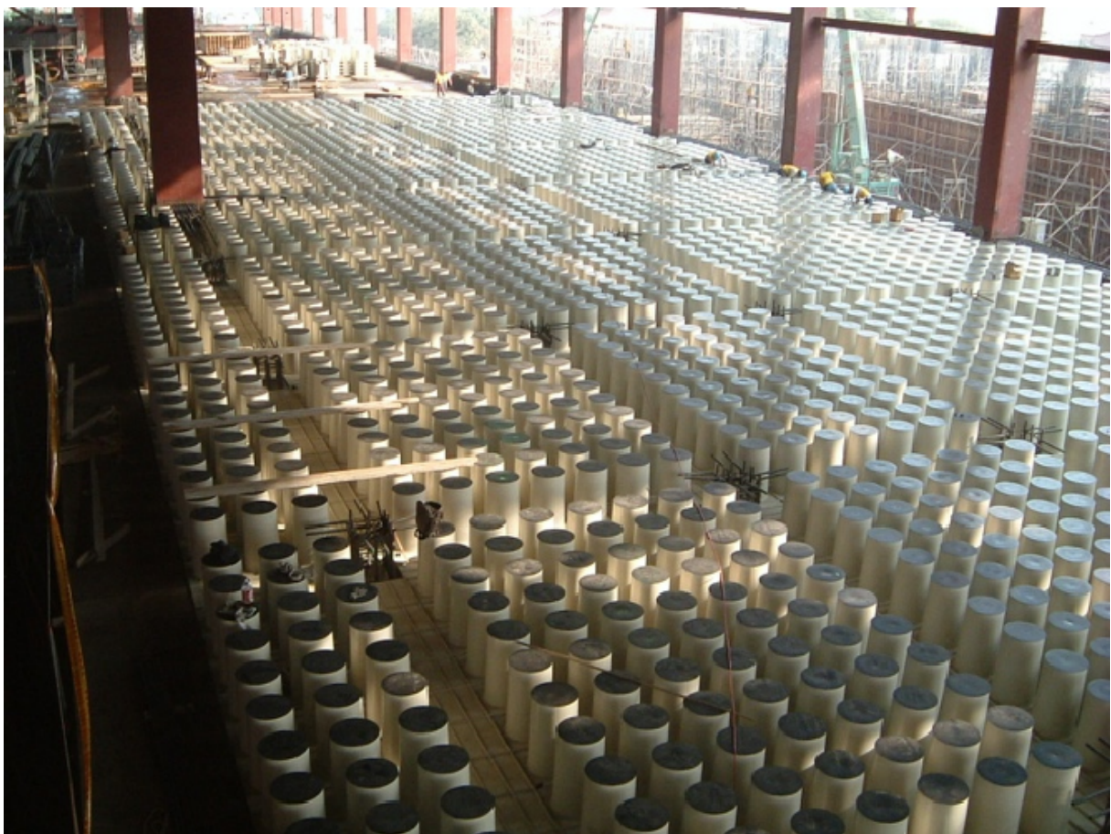
SMC洞洞板模板組立
